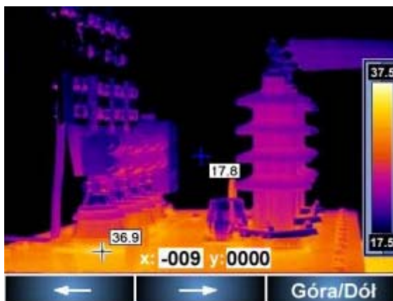
Рисунок 10. Установка новой точки постоянного отсчета температуры по горизонтали
